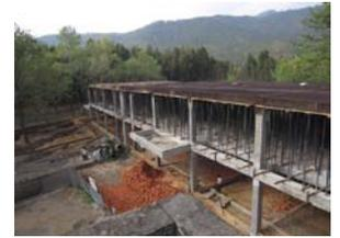
重機による作業が主な日本での施工管理に比べ、ネパールではほとんどの作業が、機械ではなく「人力」により進められます。日本の建設現場では、ショベルカー、コンクリートミキサー車、クレーン車などの重機が見られますが、こちらにあるのは、モルタルミキサー（コンクリートを混ぜる機械）やバイブレーター（コンクリートに振動を与えて、締め固める機械）程度です。基礎工事の根切り作業では、40度を超える暑さの中、屈強なネパール人作業員が、スコップでどンドン穴を掘り進めていました。また、二階部分の鉄筋の組み立て作業では、作業員が鉄筋の束をロープで縛り、地面から人力で引き上げていました。
