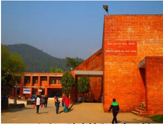
正面から入院病棟と左奥に新周産期病棟を臨む
